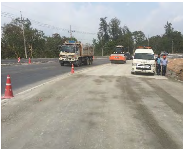
ภาพที่ 30.1 พื้นที่ชั้นทาง CTB ก่อนการดำเนินการ Microcracking
