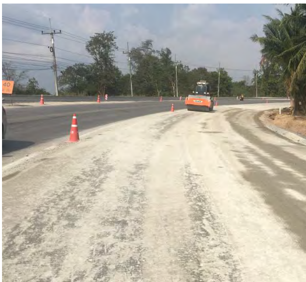
ภาพที่ 30.3 การดำเนินการ Microcracking พื้นที่ชั้นทาง CTB ด้วยรถบดล้อเหล็กแบบสันสะเทือน
